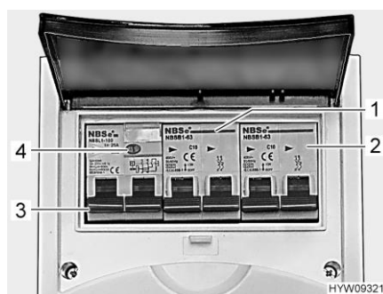
Fig. 60 Interruttore di sicurezza e interruttore automatico FI (scatola dei fusibili a 230 V)
