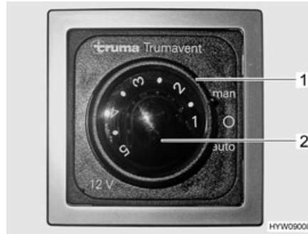
Fig. 94 Interruttore di comando (ventola di ricircolo dell'aria (12 V))
