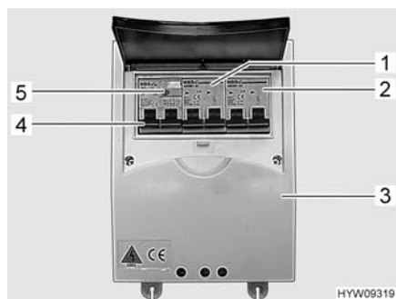
Fig. 83 Interruttore di sicurezza e interruttore automatico FI (scatola dei fusibili a 230 V)
