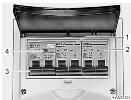
Fig. 102 Interruttore di sicurezza e interruttore automatico FI (scatola dei fusibili a 230 V)
