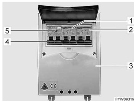
Fig. 84 Interruttore di sicurezza e interruttore automatico FI (scatola dei fusibili a 230 V)
