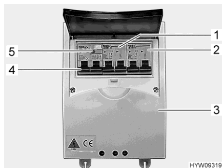
Fig. 96 Interruttore di sicurezza e interruttore automatico FI (scatola dei fusibili a 230 V)
