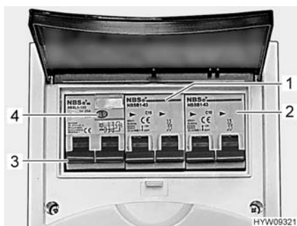
Fig. 106 Interruttore di sicurezza e interruttore automatico FI (scatola dei fusibili a 230 V)
