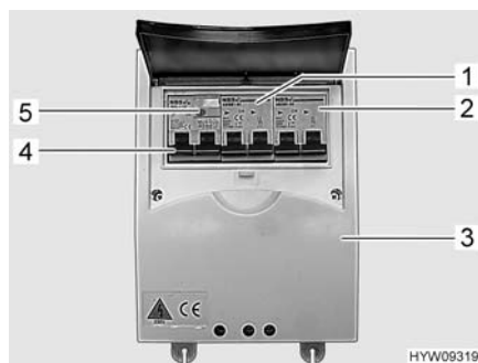
Fig. 111 Interruttore di sicurezza e interruttore automatico FI (scatola dei fusibili a 230 V)
