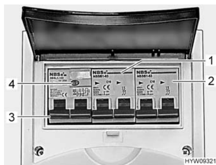
Fig. 119 Interruttore di sicurezza e interruttore automatico FI (scatola dei fusibili a 230 V)
