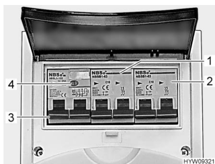
Fig. 133 Interruttore di sicurezza e interruttore automatico FI (scatola dei fusibili a 230 V)
