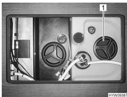
Fig. 205 Apertura per la pulizia (serbatoio dell'acqua)
