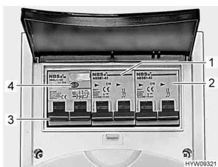
Fig. 145 Interruttore di sicurezza e interruttore automatico FI (scatola dei fusibili a 230 V)
