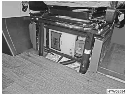
Fig. 55 Scatola dei fusibili 230 V (ubicazione)
