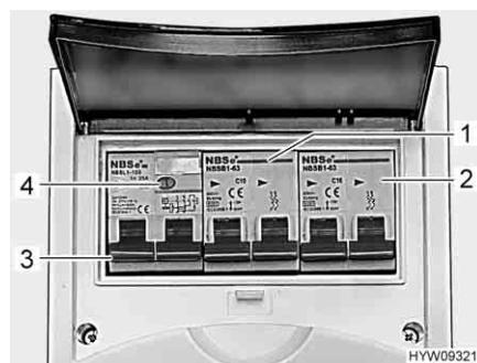
Fig. 100 Interruttore di sicurezza e interruttore automatico FI (scatola dei fusibili a 230 V)
