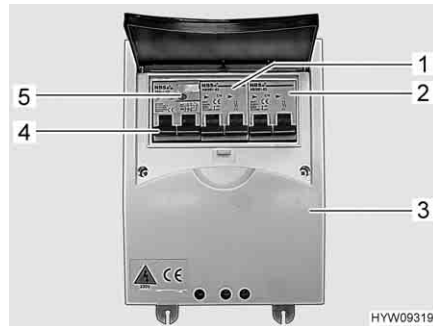
Fig. 92 Interruttore di sicurezza e interruttore automatico FI (scatola dei fusibili a 230 V)
