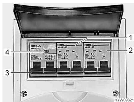
Fig. 113 Interruttore di sicurezza e interruttore automatico FI (scatola dei fusibili a 230 V)
