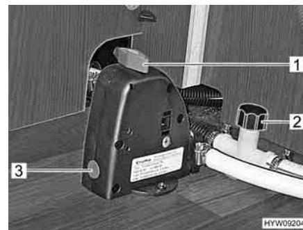
Fig. 113 Valvola di sicurezza/di scarico e rubinetto di scarico (boiler Truma Combi)
