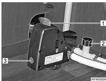
Fig. 159 Valvola di sicurezza/di scarico (solo per boiler Truma Combi)
