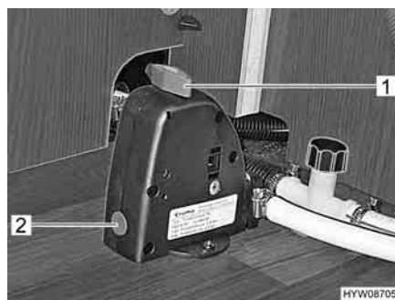
Fig. 136 Valvola di sicurezza/di scarico del boiler
