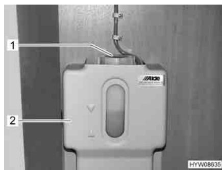
Fig. 171 Vaso d'espansione del riscaldamento ad acqua calda (armadio guardaroba)
