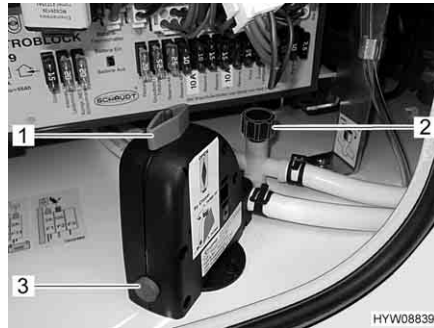
Fig. 118 Valvola di sicurezza/di scarico del boiler
