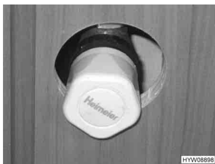
Fig. 135 Valvola di chiusura con manopola
