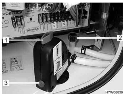
Fig. 148 Valvola di sicurezza/di scarico del boiler
