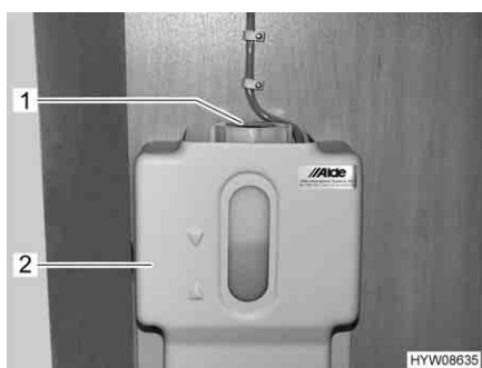
Fig. 119 Vaso d'espansione del riscaldamento ad acqua calda
