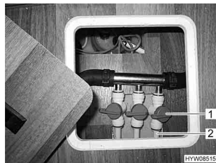
Fig. 82 Valvole di ritorno del riscaldamento a pavimento
