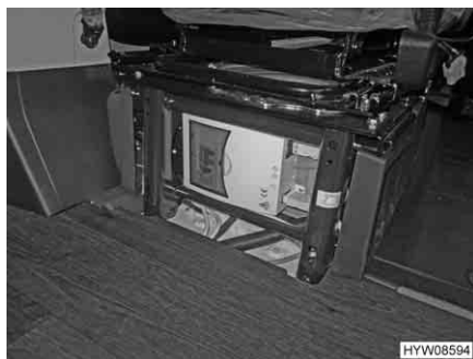
Fig. 51 Ubicazione scatola dei fusibili a 230 V (Fiat)
