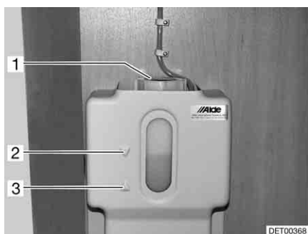
Fig. 161 Vaso d'espansione del riscaldamento ad acqua calda
