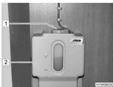
Fig. 160 Vaso d'espansione del riscaldamento ad acqua calda (armadio guardaroba)
