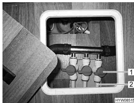
Fig. 73 Valvole di ritorno del riscaldamento a pavimento
