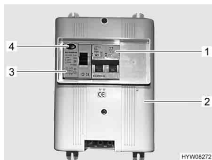
Fig. 93 Scatola dei fusibili a 230 V con interruttore di sicurezza e interruttore automatico FI
