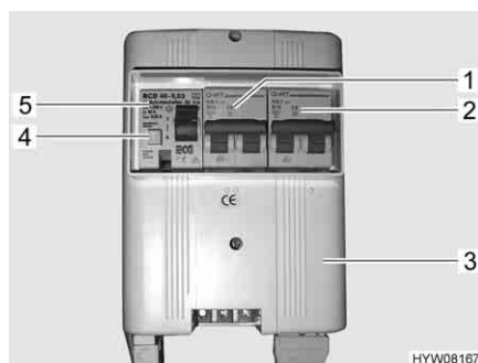
Fig. 98 Scatola dei fusibili a 230 V con interruttore di sicurezza e interruttore automatico FI
