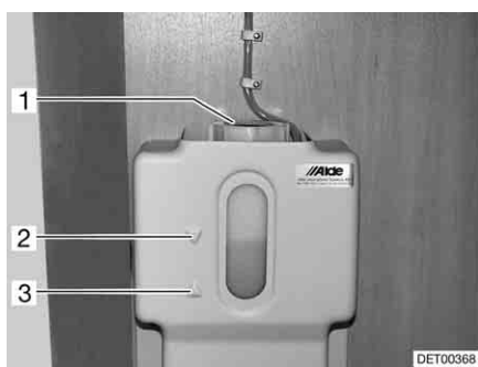
Fig. 123 Vaso d'espansione del riscaldamento ad acqua calda
