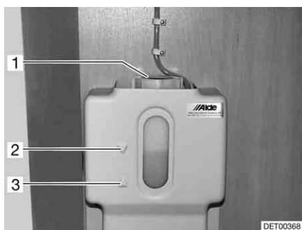
Fig. 165 Vaso d'espansione del riscaldamento ad acqua calda
