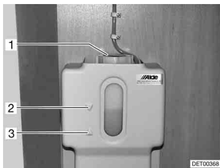
Fig. 227 Vaso d'espansione del riscaldamento ad acqua calda
