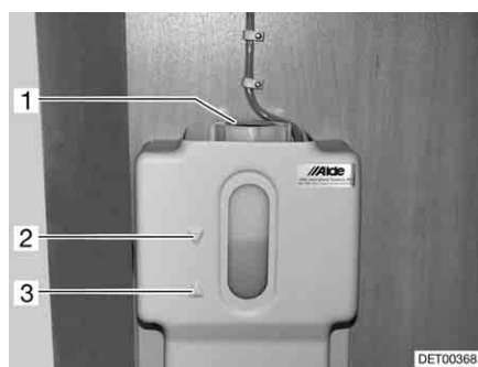
Fig. 223 Vaso d'espansione del riscaldamento ad acqua calda
