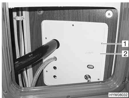
Fig. 220 Toilette parete posteriore
