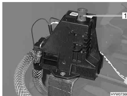
Bild 177 Sicherheits-/Ablassventil des Boilers
