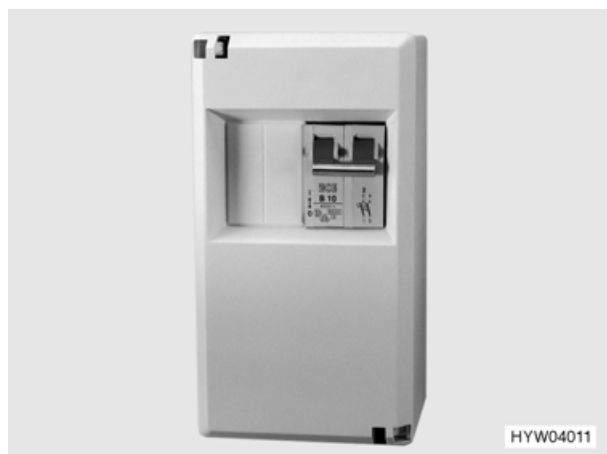
Fig. 40 Scatola dei fusibili a 230 V con interruttore di sicurezza
